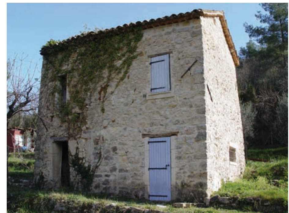
En cours de réhabilitation
